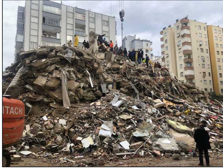
Şekil 2. 6 Şubat 2023 tarihli ilk ilk depremde Adana'da yıkılan bir bina
